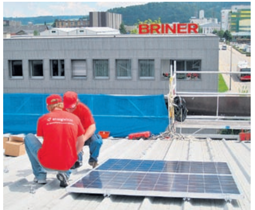
Dieser Tage begann die Montage des Solarkraftwerks auf dem Hallendach. Bild: pd
